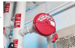
Sécurisation de vannes à boisseau sphérique grâce au système universel de condamnation de vannes : la baguette de condamnation bloque l'utilisation de la vanne.
